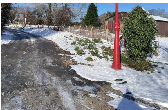
Lotissement/Eclairage public et goudronnage du chemin des Ecoliers imminent.
